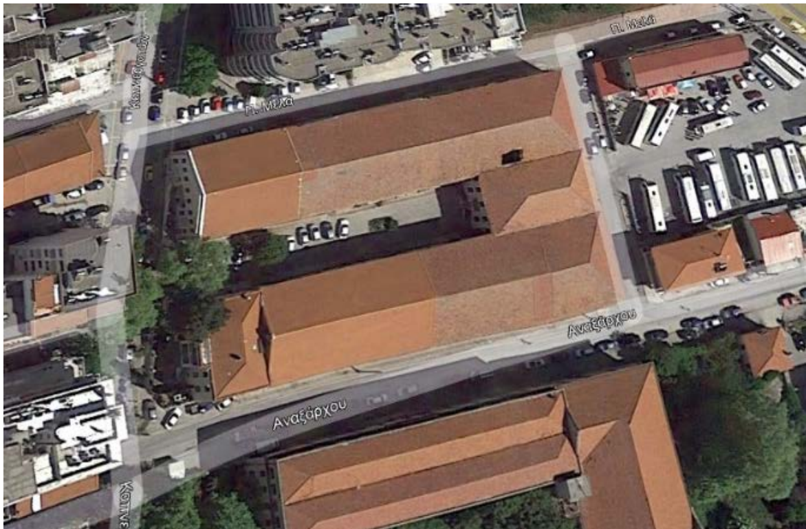
Εικόνα 23 Γενική άποψη της επιστέγασης της Καπναποθήκης Π
