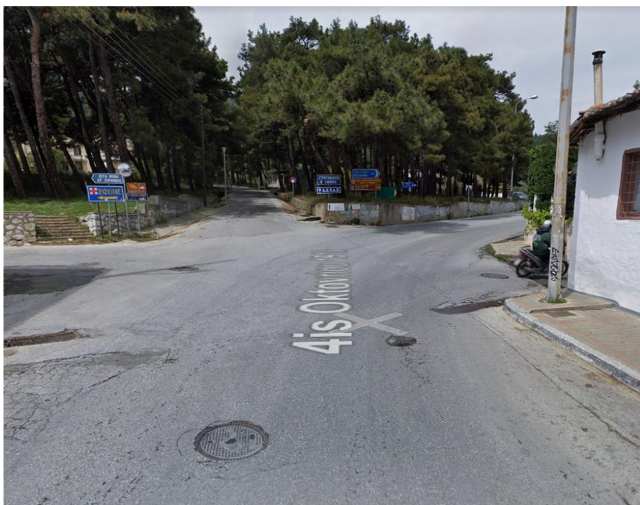
Εικόνα 79. Υφιστάμενη κατάσταση Κόμβου 9, (Πηγή: Google StreetView)
