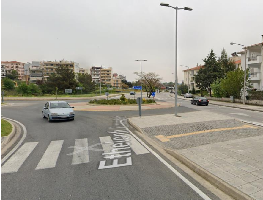
Εικόνα 76: Υφιστάμενη κατάσταση Κόμβου 6, (Πηγή: Google StreetView)
