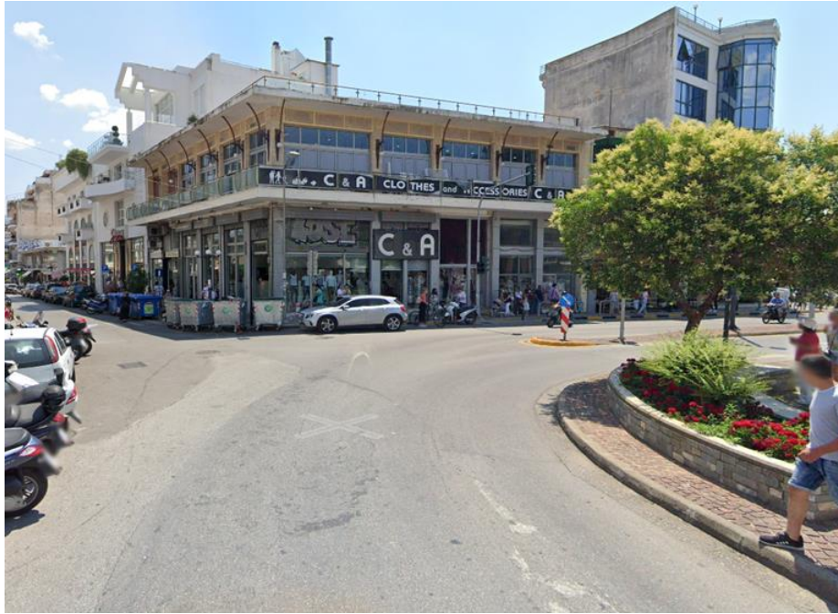
Εικόνα 78: Υφιστάμενη κατάσταση Κόμβου 8, (Πηγή: Google StreetView)
