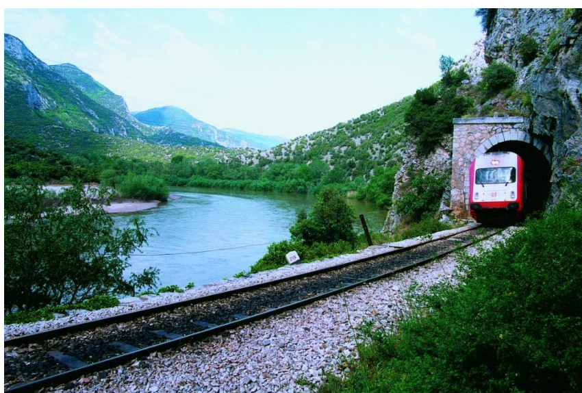
Εικόνα 64: Διαδρομή Σιδηροδρόμου ΟΣΕ κατά μήκος των Στενών του Νέστου - Δήμος Ξάνθης
