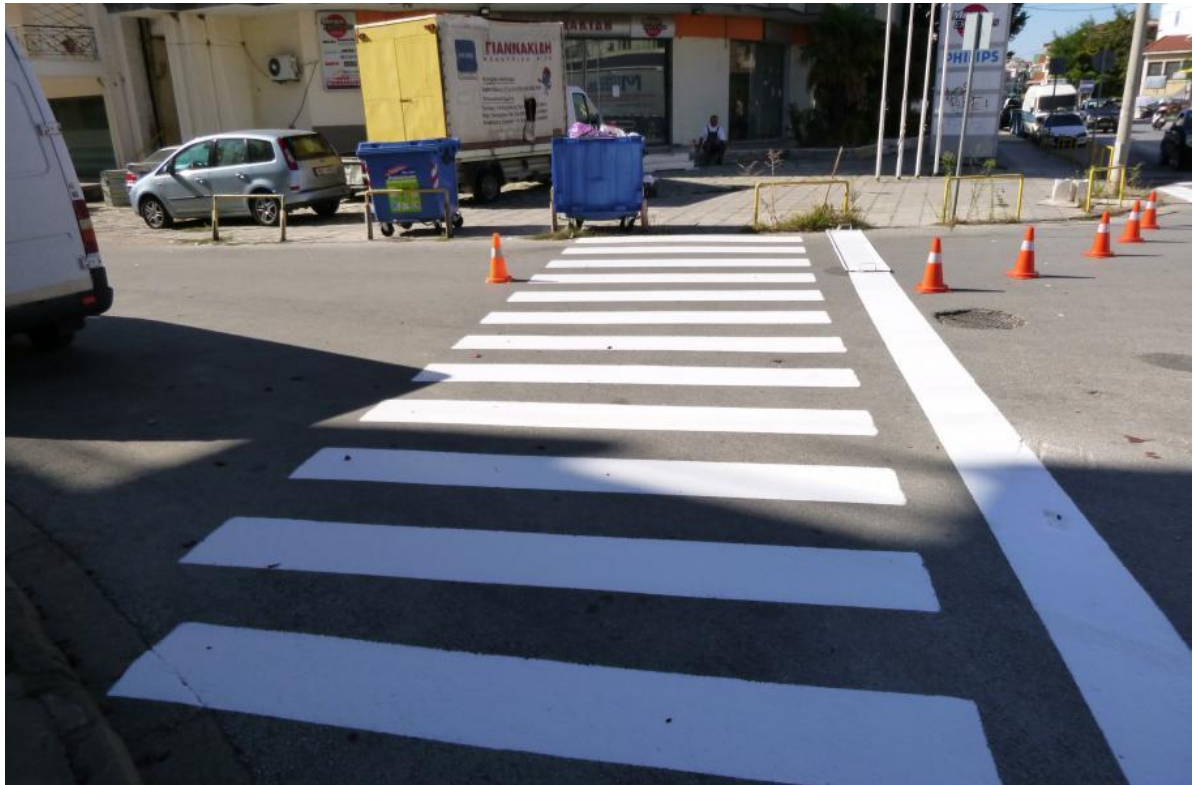
Εικόνα 60: Νέος χρωματισμός διαβάσεων στη Λεωφόρο Στρατού (Πηγή: Google maps)
