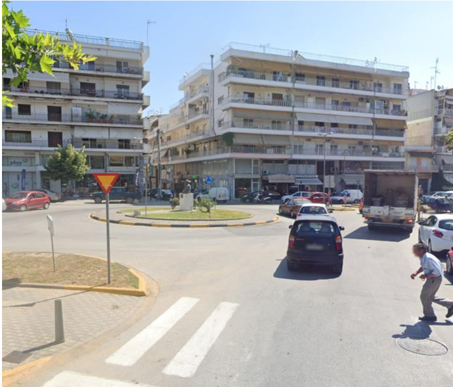
Εικόνα 77. Υφιστάμενη κατάσταση Κόμβου 7, (Πηγή: Google StreetView)
