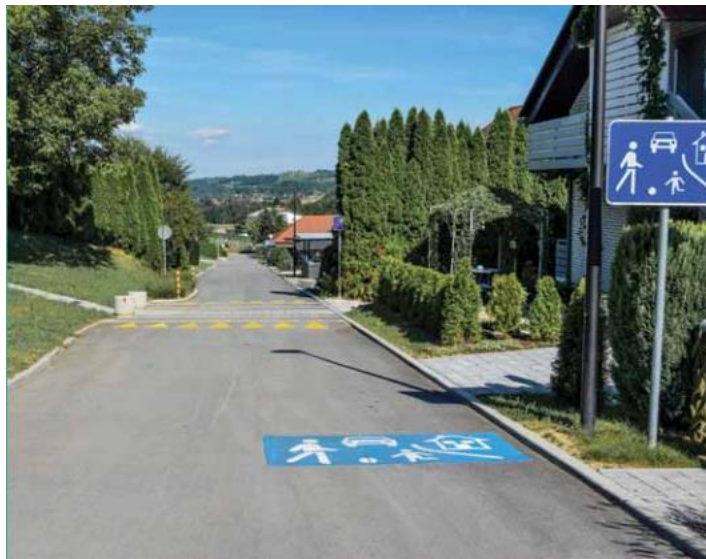
Εικόνα 3: Low – cost παρέμβαση για θεσμοθέτηση περιοχής ήπιας κυκλοφορίας με υπερυψωμένη διάβαση σε γειτονιά της Ljutomer, Πηγή: : www.eltis.org
